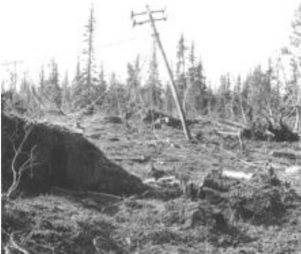
Figur 48: Bild efter provsprängning av tidstypiskt telenät. (Foto:CVA/FMV)
