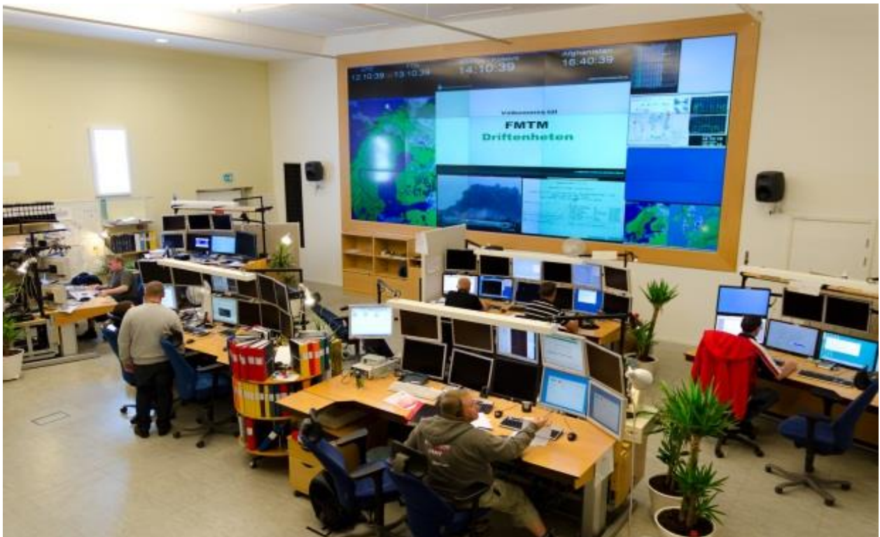
Figur 31: Teledriftcentralen (Foto: FMTM)
